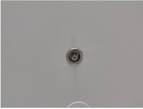
รูปที่ 29 ระบบหัวกระจายน้ำดับเพลิงอัตโนมัติ
