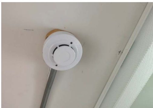
รูปที่ 22 เครื่องตรวจจับควัน (Smoke Detector)
